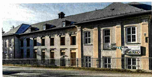
Auch von außen ist das Gebäude eine Baustelle. Die Fenster der unteren Reihe des Saales sind wegen der eingezogenen Decke verkleinert worden, die oberen Fenster wurden vergrößert. FOTOS: JENS UHLIG
